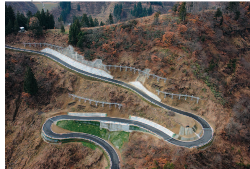
新潟県長岡市山古志梶金地内 (発注者:長岡市役所)
