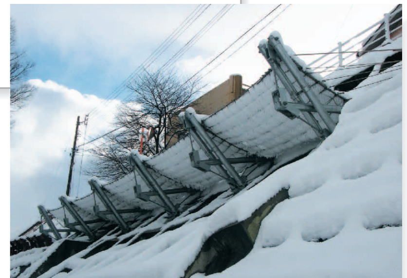
新潟県小千谷市千谷川地内 (発注者:新潟県長岡地域振興局災害復旧部:小千谷地区担当)
