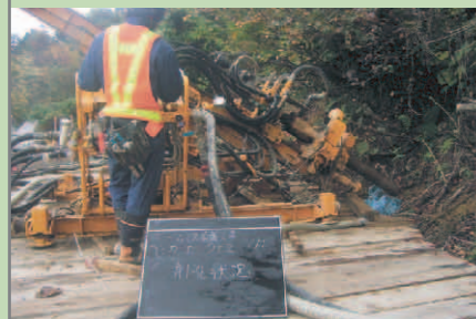
3. アンカー削孔
