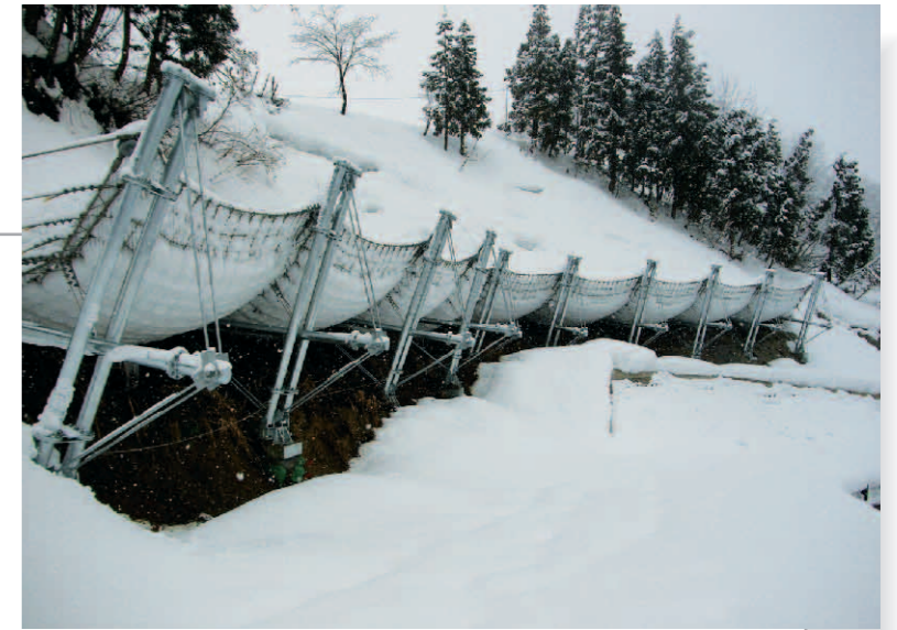
新潟県長岡市山古志梶金地内 (発注者:長岡市役所)
