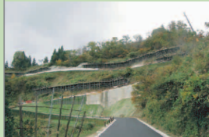
2. 足場組み立て
