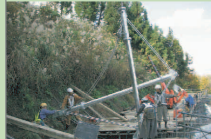
6-2. 柱ユニット設置
