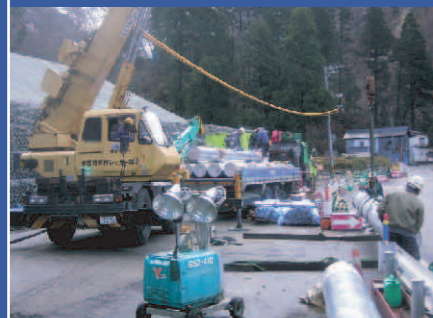
3. 資材の搬入 資材を現場に搬入します。
