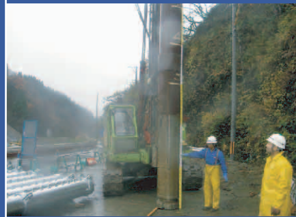
2. 施工機械の搬入 施工機械を搬入し、削孔の準備を行います。
