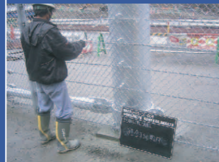
12. 金網の設置 金網を結合コイル、間隔保持材を用いて固 定します。
