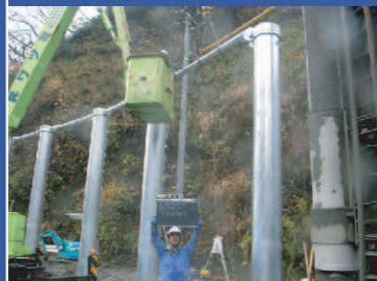
8. サポート材、上弦材の取り付け サポート材、上弦材を取り付け、支柱を連続 構造とします。
