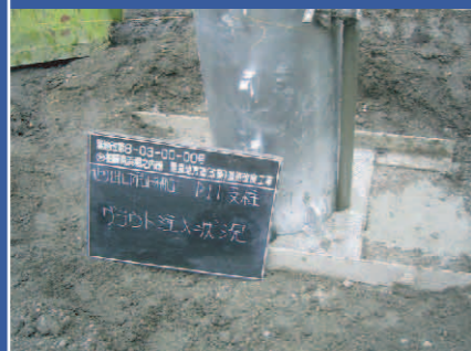
7. 充填工(支柱基部のグラウト材注入) 支柱と孔壁の隙間にグラウト材を注入します。
