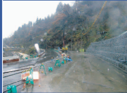
1. 準備工 準備工では、PSTを設置するための位置出し 測量および機材の選定を行います。
