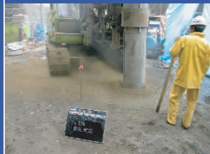
4. 大口径ボーリング工 支柱を建て込むために大口径ボーリングマン ンにより削孔を行います。アンカータイプの場合 は先にアンカーの施工を行います。
