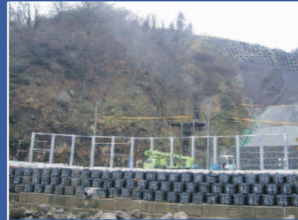
9. 支柱建て込み完了
