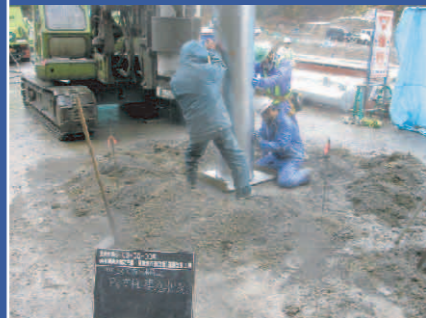
6. 支柱の建て込み クレーンを用いて支柱を建て込みます。
