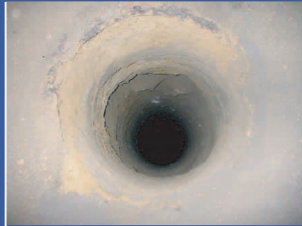
5. 削孔完了状況
