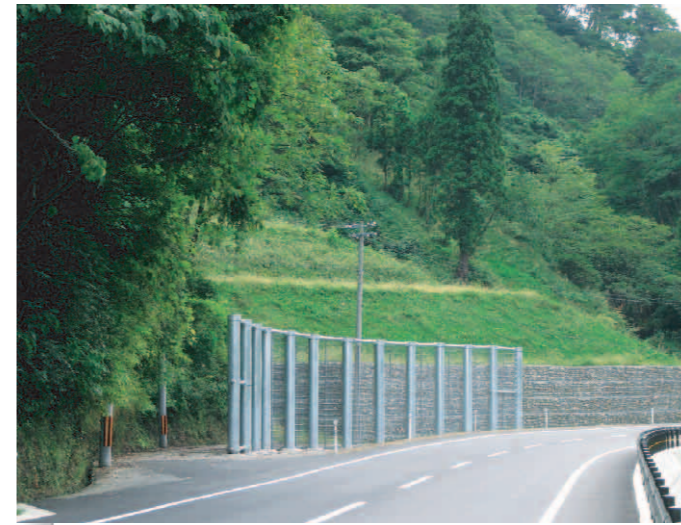
新潟県長岡市濁沢地内 (発注者:新潟県長岡地域振興局)
