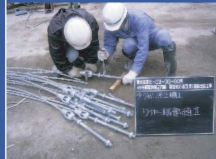
10. ガードロープ組立 ガードロープの切断、組み立てを行います。
