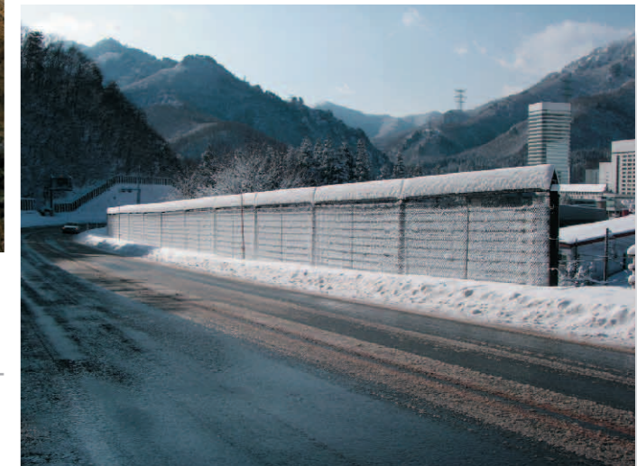
新潟県南魚沼郡湯沢町大字三国地先 (発注者:北陸地方整備局長岡国道工事事務所)
