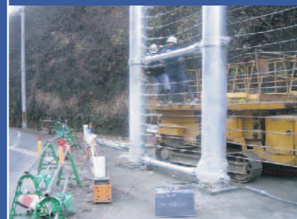
11. ガードロープの取り付け
