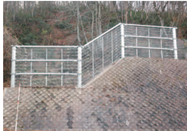
縦断勾配のある現場に設置した事例
