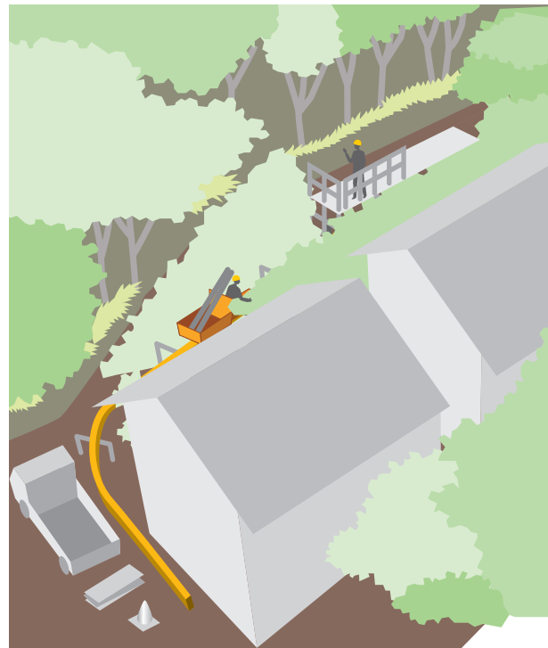
モノレールによる支柱鋼管の搬入
