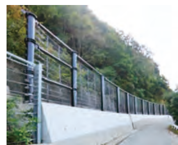
せり出し防止・落石防護兼用柵
