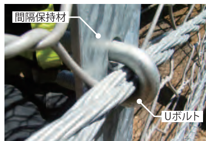
ワイヤロープは支柱の山側を通して設置します。また、荷重を受けた際にワイヤロープが広がるのを防ぐため、間隔保持材で固定します。
