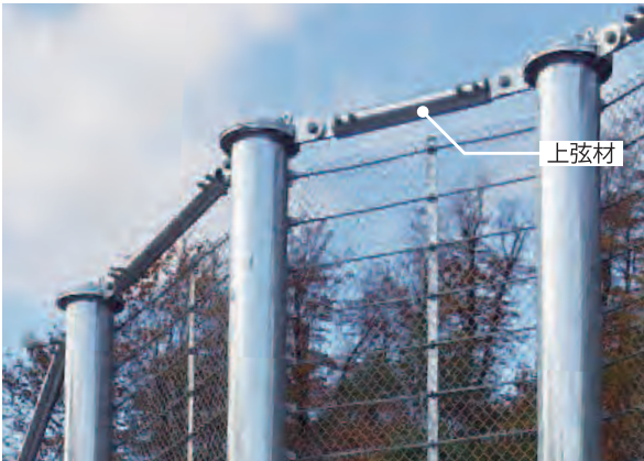
上弦材を設置する支柱頭部は前後および上下に角度を調節して取り付けられるユニバーサル構造です。
