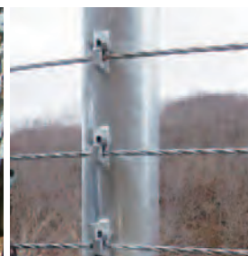
ワイヤロープは支柱の山側を通して設置します。また、荷重を受けた際にワイヤロープが広がるのを防ぐため、間隔保持材で固定します。
