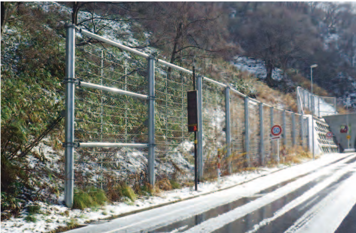
上弦材を設置する支柱頭部は前後および上下に角度を調節して取り付けられるユニバーサル構造です。
