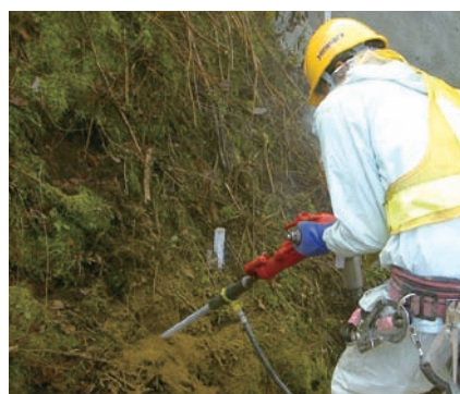
大型の削孔機を必要としない自穿孔アンカー
