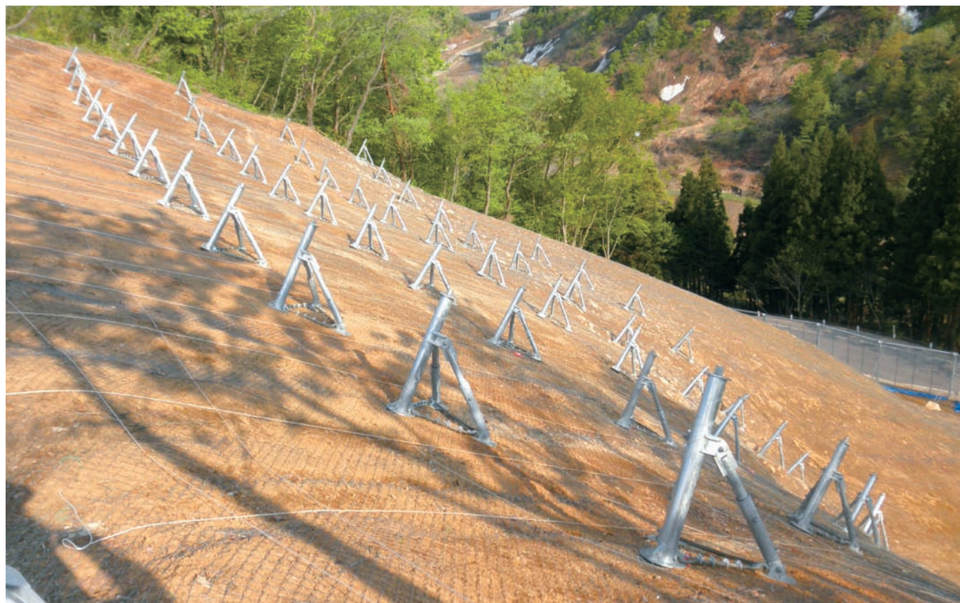
設置例 | 設置数 60基 施工期間 20日程度(アンカー基礎工含)
